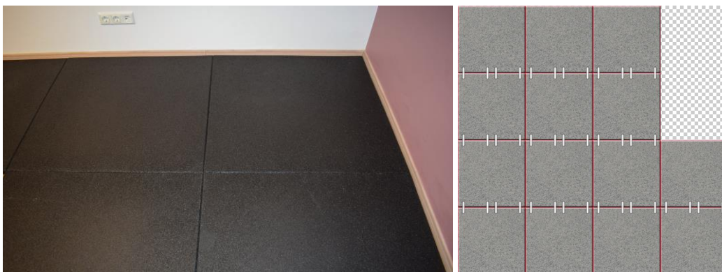
Platten zusammendrücken; Verlegung der Platten im Schachbrettmuster
