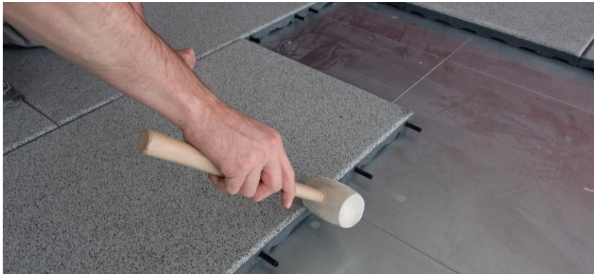
Schließen von Lücken mit einem Hammer
