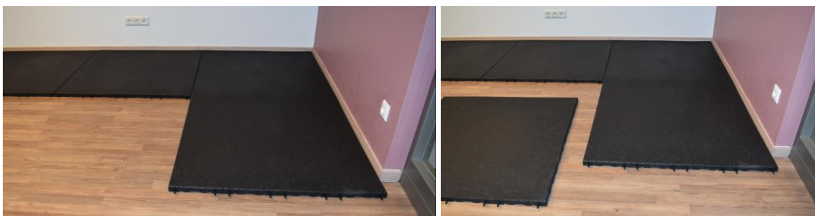
Die zweite Reihe mit den Platten genauso beginnen und fortfahren; Platte neben Platte legen
