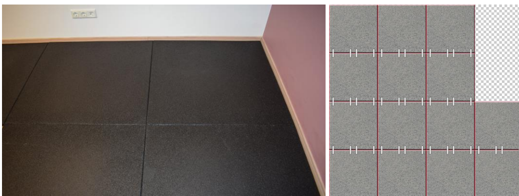
Platten zusammendrücken; Verlegung der Platten im Schachbrettmuster
