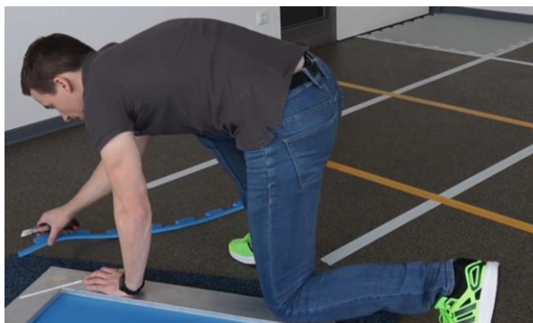
Zuschnitt der Matte für eine gerade Kante ineinandergreifen der Zähne im Verbund
