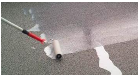
Auftragen der Versiegelung
