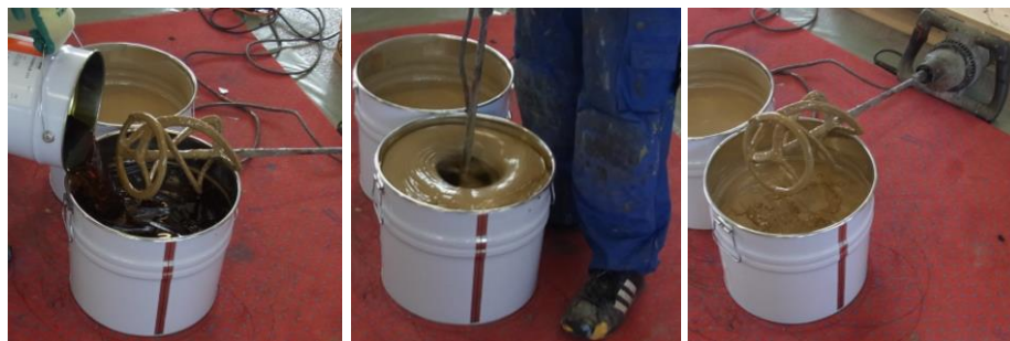
Anrühren des 2-Komponenten PU-Klebers
