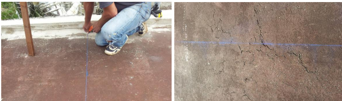
Erstellen von Kreidelinien als Verlegehilfe
