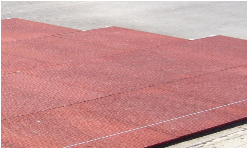
Verlegung der Platten entlang einer Randeinfassung
