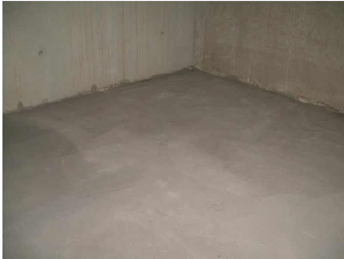
glatter, geeigneter Untergrund aus Betonestrich
