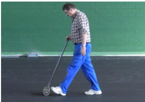
Abrollen des Belages mit einer Anpresswalze
