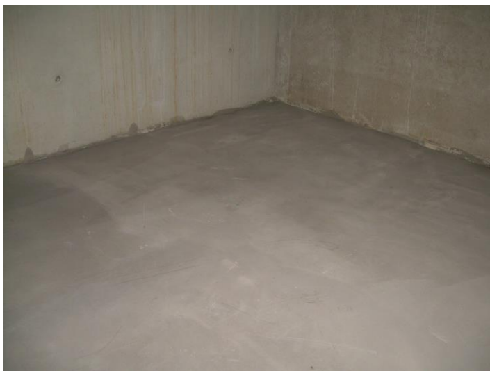
Glatter, geeigneter Untergrund aus Betonestrich
