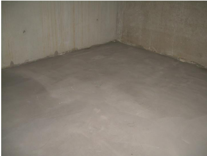
glatter, geeigneter Untergrund aus Betonestrich
